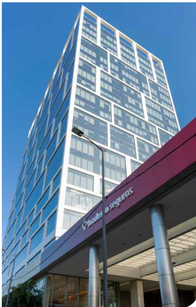
O edifício de alto padrão possui 20 andares, assentado em 37 m 2
